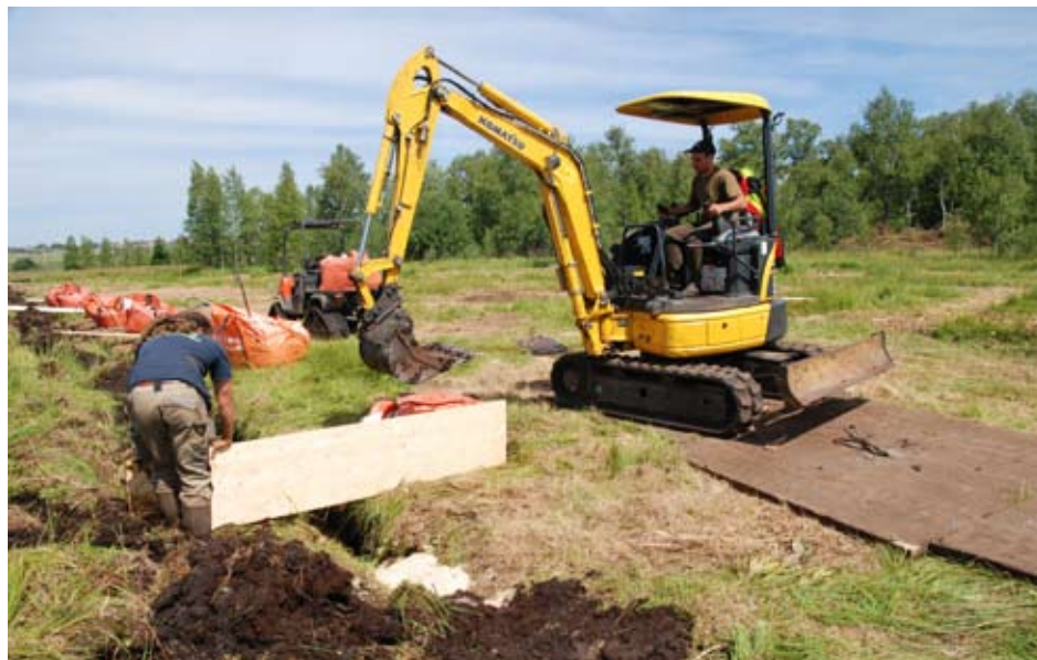
Fot. 54. Przegroda ze sklejk wciskana w torfowisko, w szczelinę (wcześniej zrobioną za pomocą grubej blachy wciśniętej i wyciągniętej koparką) za pomocą małej koparki. Widoczne w tle worki wypełnione trocinami do wypełnienia odcinków rowu pomiędzy zastawkami. Torfowisko w regionie Franche-Comté na Jurze, Francja (por. także rozdz. 7; fot. R. Stańko).
