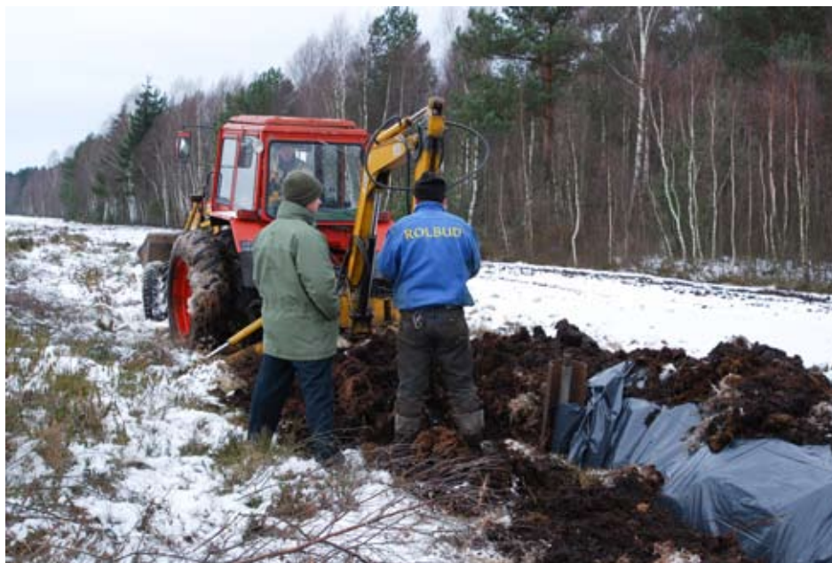
Fot. 57. Montaż folii plastikowej na obrzeżach torfowiska w celu ograniczenia jego odwadniania przez sąsiadujący rów melioracyjny (fot. R. Stańko).
