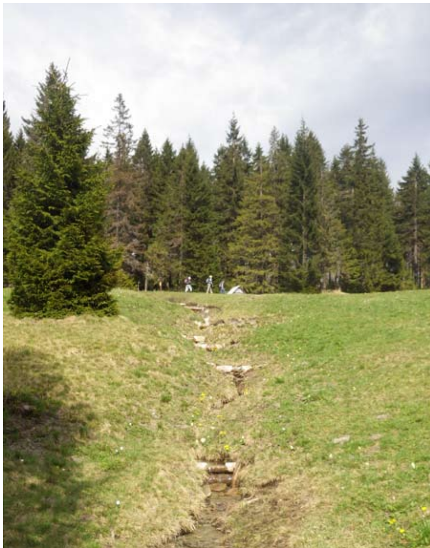
Fot. 98. Blokowanie odpływu wody z młak w Gorczańskim Parku Narodowym. Z obszaru wcześniej zostały usunięte drzewa i krzewy. Działanie realizowane w ramach projektu „Ochrona torfowisk alkalicznych południowej Polski” (fot. D. Horabik).
