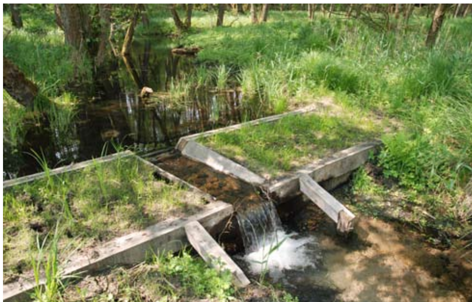
Fot. 53. Przegroda drewniana z dwóch ścianek szczelnych z wypełnieniem. Doskonale sprawdza się w rowach i ciekach o znaczącym przepływie wody (obiekt Mielęcino-Bukowo w Puszczy Drawskiej; fot. R. Stańko).
