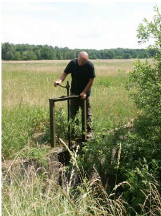
Fot. 55. Betonowa zastawka z regulowanym piętrzeniem za pomocą metalowej zastawy (fot. B. Utracka-Minko).
