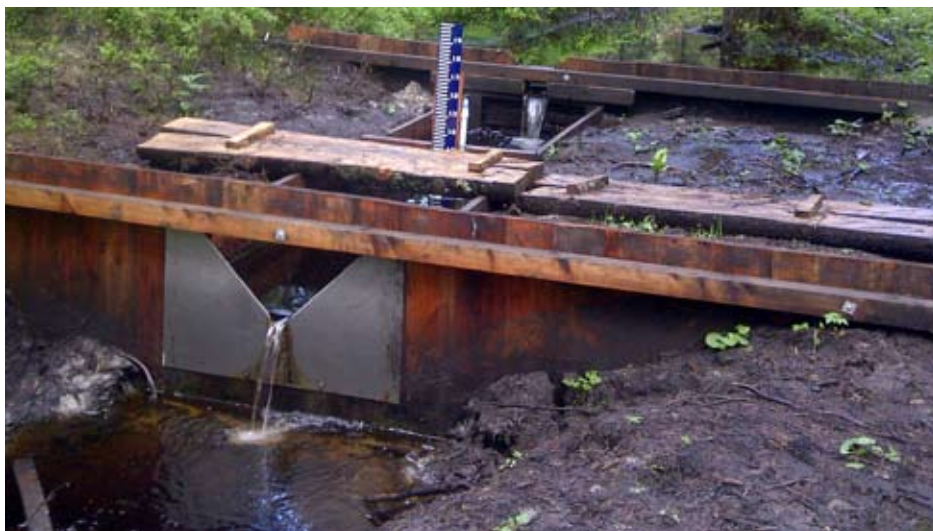
Fot. 83. Przegroda drewniana z V-kształtnym metalowym przelewem na torfowisku Löckernmoos (fot. M. Makles).
