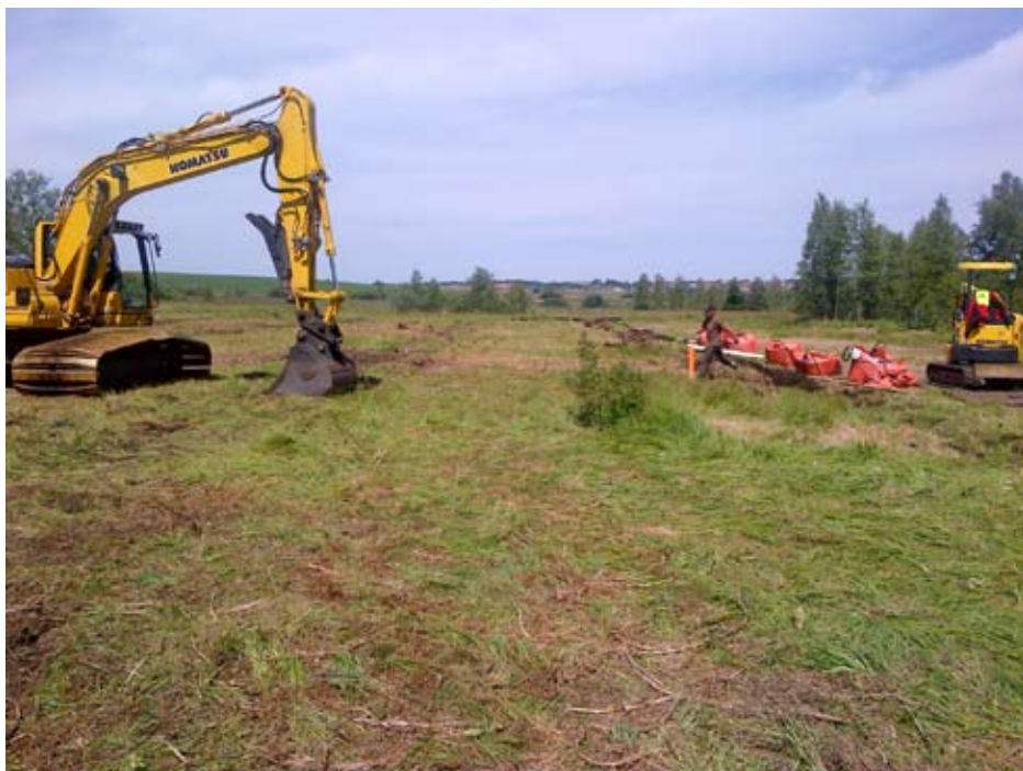
Fot. 90. Całość po zakończeniu jest dodatkowo ubijana przez ciężki sprzęt budowlany (fot. M. Makles).
