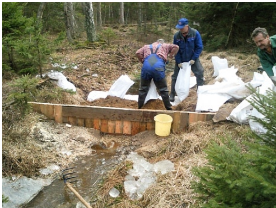
Fot. 96. Zablockowanie rowu poprzez budowę 2 ścianek szczelnych wypełnionych wewnątrz gliną, a z wierzchu miejscowym torfem (źródło: http://www.kp.org.pl/plbaltbogs/ ).
