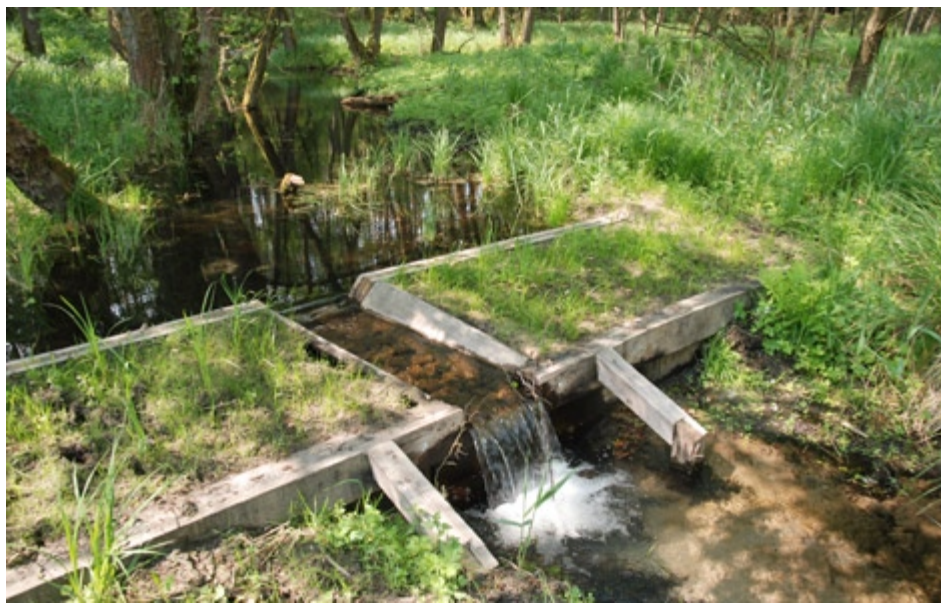
Fot. 53. Przegroda drewniana z dwóch ścianek szczelnych z wypełnieniem. Doskonale sprawdza się w rowach i ciekach o znaczącym przepływie wody (obiekt Mielęcín-Bukowo w Puszczy Drawskiej; fot. R. Stańko).
