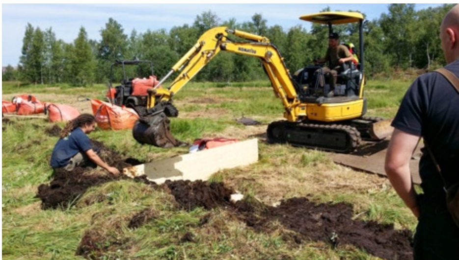
Fot. 89. Prace związane z zamknięciem przepływu w rowach odwadniających. Drewniane jednolite ścianki wbijane są w torfowisko, a rowy zasypywane są trocinami, na wierzch sypany jest torf. Franche-Comté, Francja (fot. D. Horabik).
