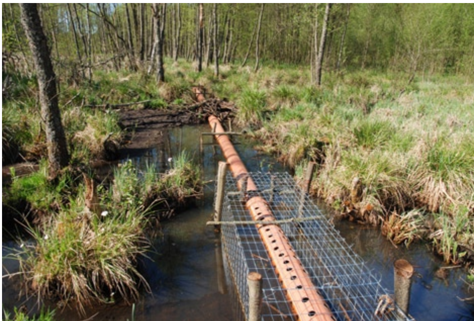
Fot. 59. Przypadki negatywnego, nadmiernego zalewania torfowisk przez bobry można ograniczać dzięki specjalnym rurom wstawianym w tamy. „Współpraca” z bobrami w ochronie torfowisk jest znacznie tańsza i nie wymaga żmudnych, często zupełnie zbędnych procedur prawnych (fot. R. Stańko).
