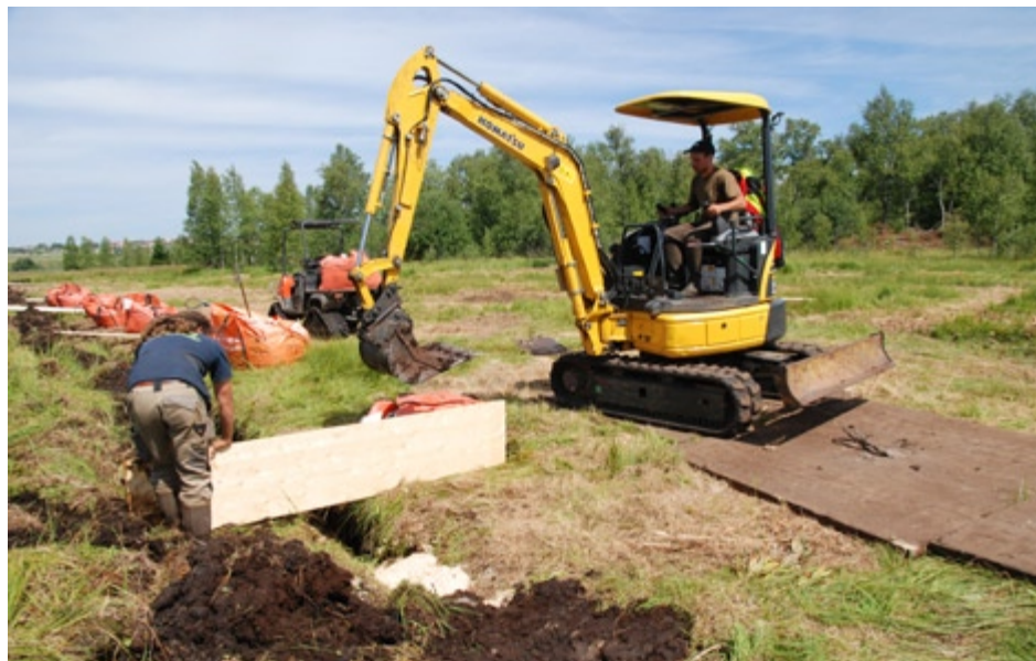
Fot. 54. Przegroda ze sklejki wciskana w torfowisko, w szczelinę (wcześniej zrobioną za pomocą grubej blachy wciśniętej i wyciągniętej koparką) za pomocą małej koparki. Widoczne w tle worki wypełnione trocinami do wypełnienia odcinków rowu pomiędzy zastawkami. Torfowisko w regionie Franche-Comté na Jurze, Francja (por. także rozdz. 7; fot. R. Stańko).
