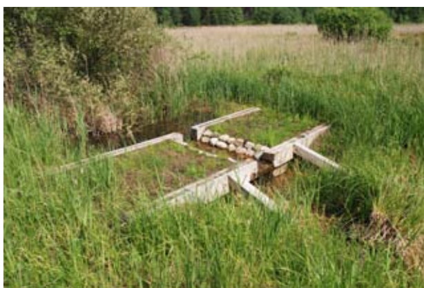
Fot. 6. Jedna spośród wybudowanych zastawek w ramach projektu LIFE11 NAT/PL/423 na stosunkowo szerokim i głębokim rowie. Zastosowanie podwójnej ścianki szczelnej z wypełnieniem ziemnym zapewnia pełną szczelność i wyklucza możliwość wszelkich rozmyć czy podmyć konstrukcji (fot. R. Stańko).
