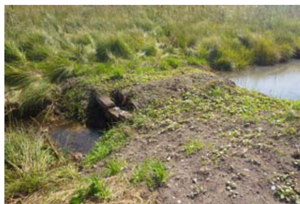
Fot. 7. Przepust „dławiący” wybudowany w ramach projektu LIFE13 NAT/PL/000024, służący ograniczeniu odpływu wody z torfowiska, nadmiar wody odprowadzany jest rurami przepustowymi (fot. D. Horabik).
