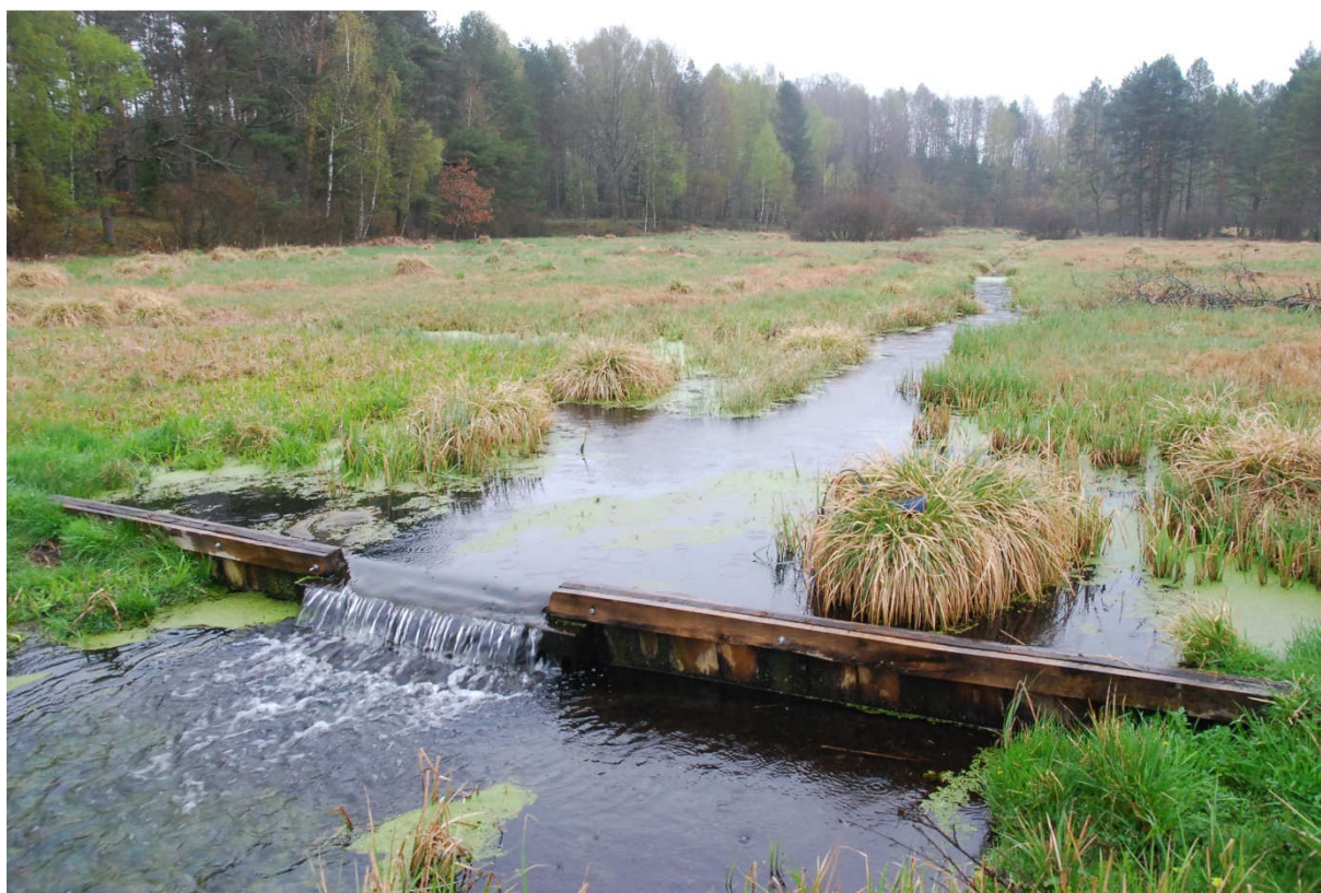
Fot. 8 Zastawka kilka miesięcy po remoncie
