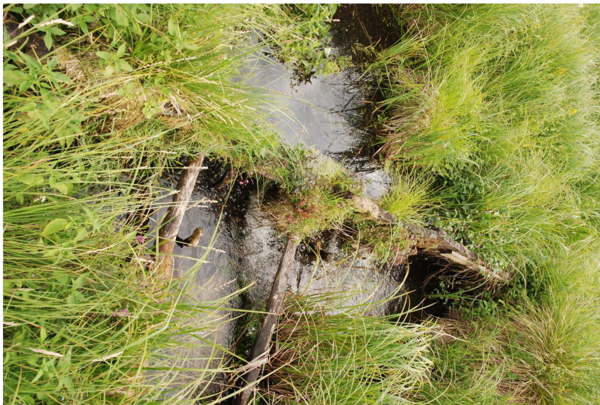
Fot. 6 Zastawka przed remontem
