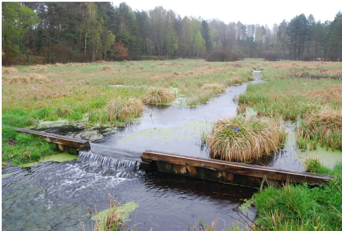
Fot. 1 Jedna z wyremontowanych w ramach projektu LIFE zastawek.
