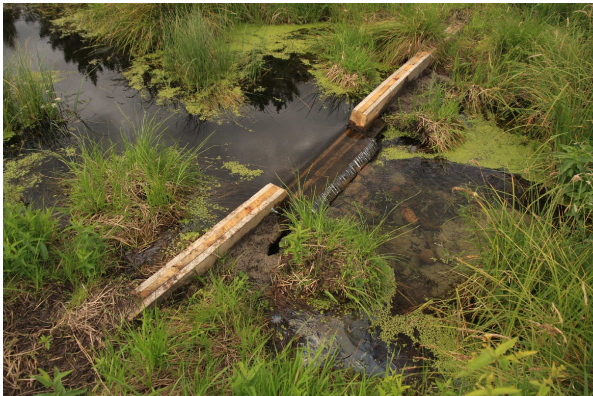
Fot. 7 Zastawka tuż po ukończeniu remontu
