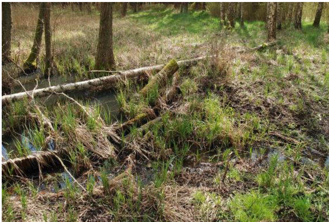
Fot. 1. Wymagająca remontu zastawka w obiekcie Ilanka VII.
