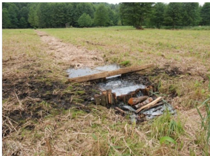
Fot. 7. Jedna z zastawek wybudowanych w ramach projektu na rowie odwadniającym torfowisko (fot. R. Stańko).
