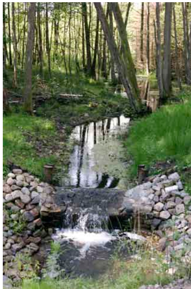
Fot. 82. Jedna z kilku zastawek wybudowanych przez Nadleśnictwo Bobolice skutecznie poprawiających warunki wodne całego kompleksu torfowiskowego (fot. D. Horabik).
