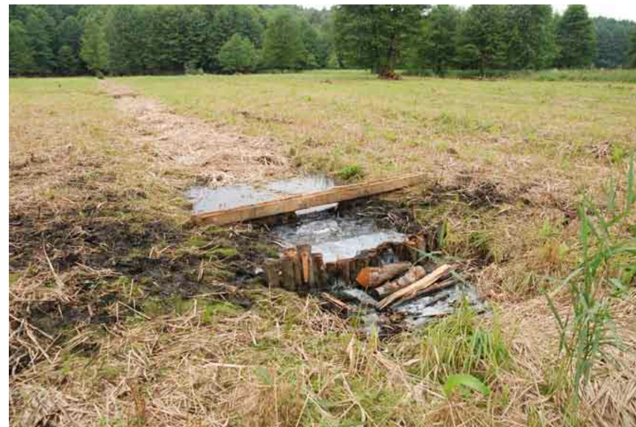
Fot. 20. Jedna z zastawek wybudowanych w ramach projektu na rowie odwadniającym torfowisko (fot. R. Stańko).
