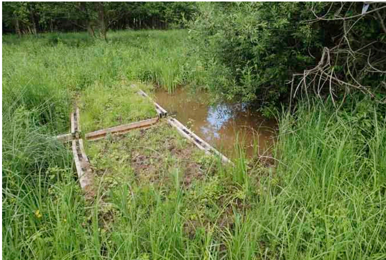
Fot. 85. Jedna z 7 zastawek wybudowanych na głębokich rowach melioracyjnych w obrębie kopały torfowiska „Płonia-Żydowo” (fot. R. Stańko).
