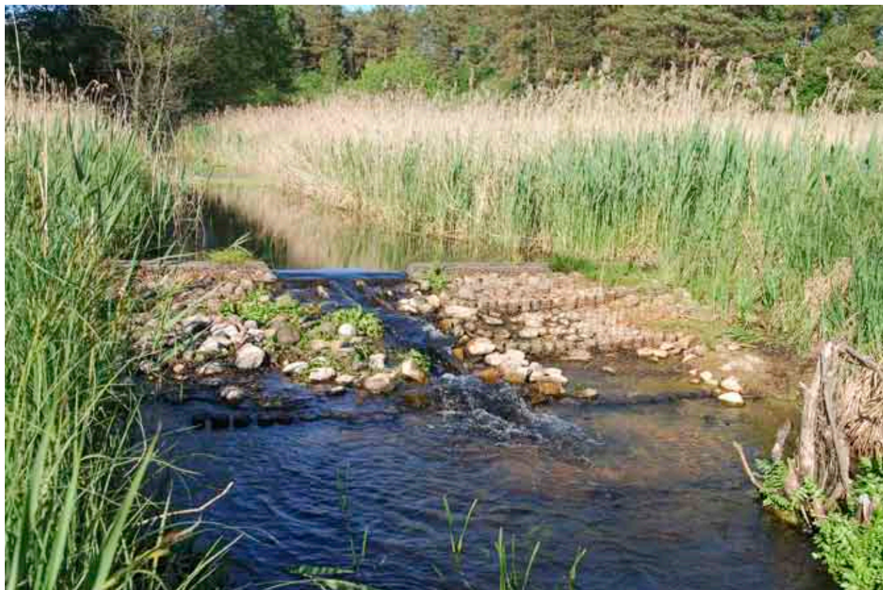
Fot. 64. Jedna z kilku największych zastawek poprawiająca warunki wodne w obrębie dużej części kompleksu torfowiskowego (fot. R. Stańko).
