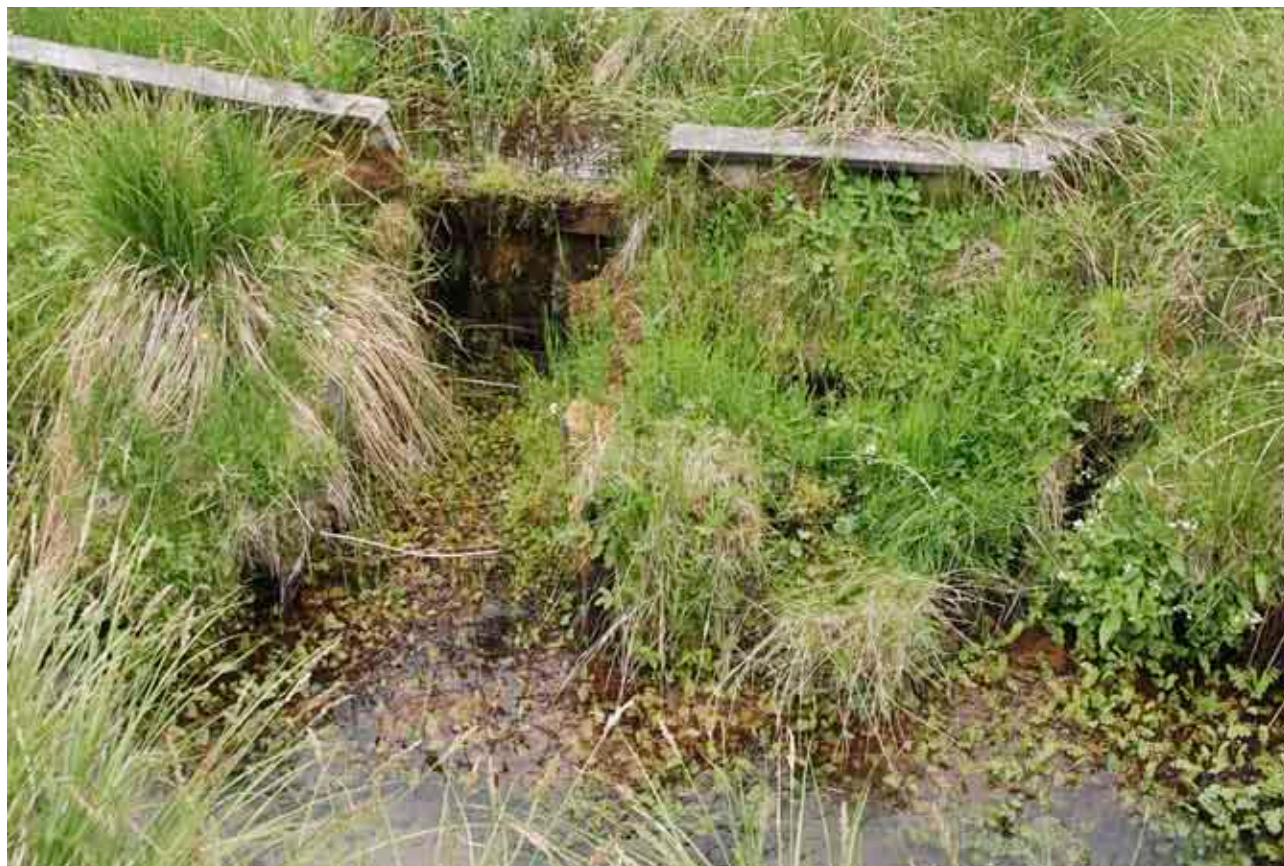
Fot. 47. Jedna z kilkunastu zastawek na rowach melioracyjnych wybudowana przed kilkunastu laty w rezerwacie „Mechowiska Czaple” przyczyniła się do niemal całkowitego zarośnięcia rowu melioracyjnego odwadniającego wiszące torfowisko źródłiskowe (fot. R. Stańko).
