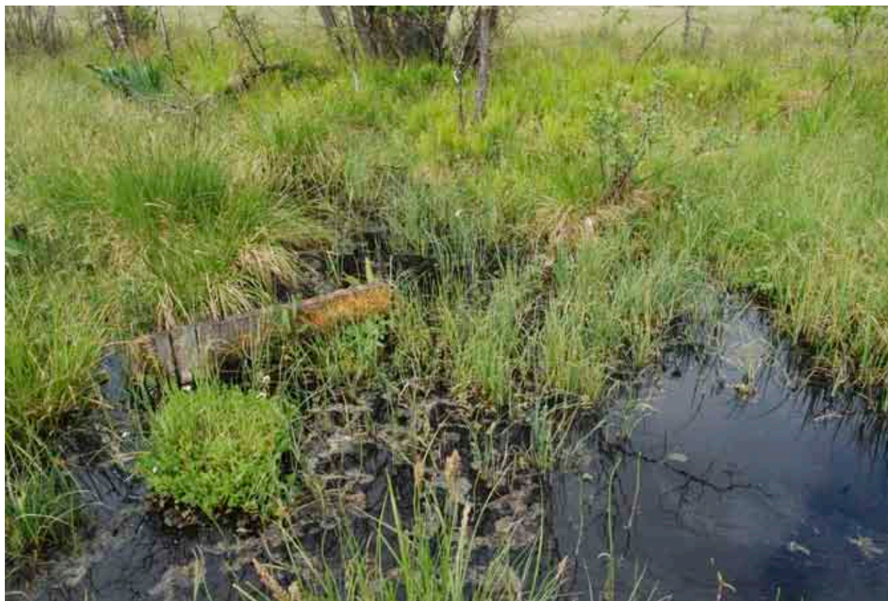
Fot. 51. Jedna z kilkunastu zastawek (rezerwat „Skotawskie Łąki”), które zostały wyremontowane w ramach projektu (fot. R. Stańko).
